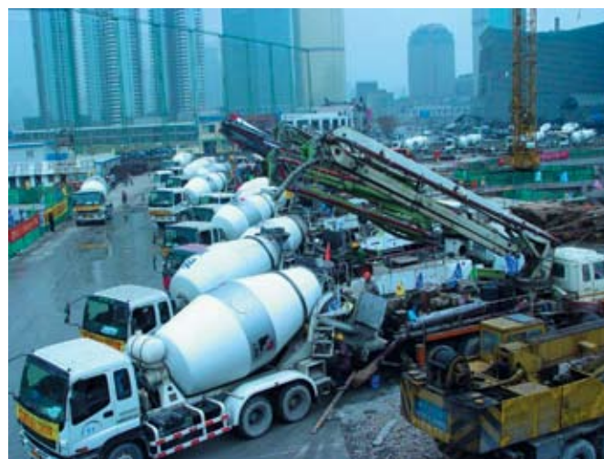
Одновременное бетонирование фундаментной плиты с помощью 19 бетононасосов
