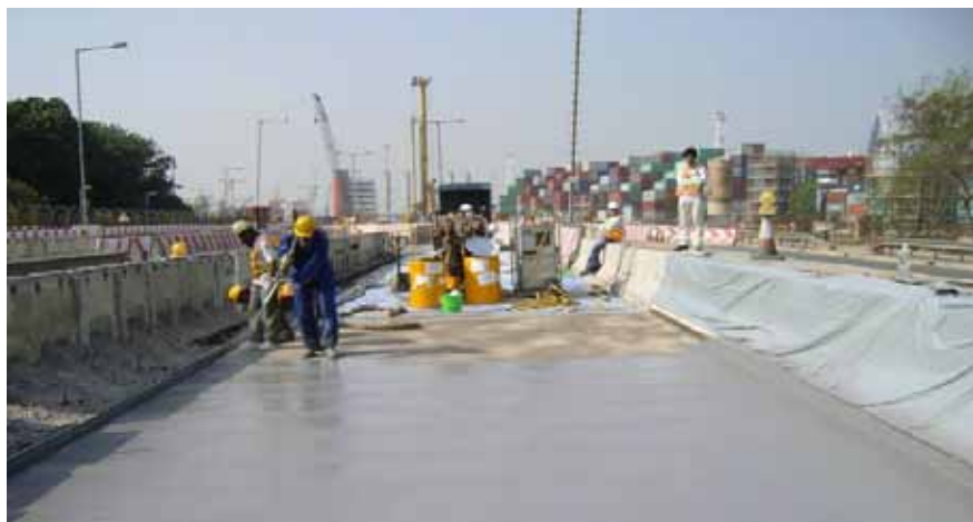
Рис. 1. Нанесение материала Sikalastic® 821 методом безвоздушного распыления
