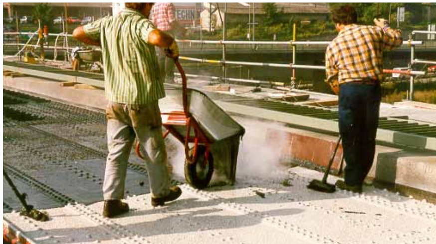
Рис.3. Гидроизоляция по металлической ортотропной плите с материалом SikaCor® HM
