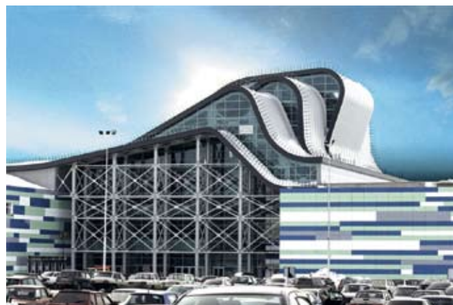
ТЦ «Сити-Парк» в Челябинске. Применение рулонных мембранных материалов Sarnafil® S 327
