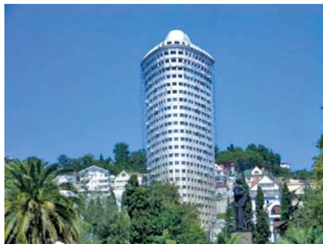
Жилой комплекс «Премьер» в Сочи. Применение мембранных рулонных материалов Sarnafil® S 327
