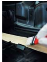
Герметизация швов с использованием кисти
