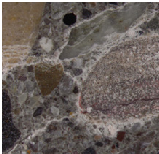
Трещина, герметизированная с помощью добавки SikaControl® WT
