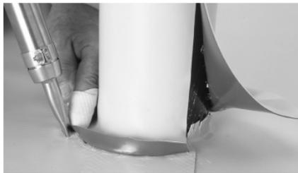
— Окончательно приварите фланец к основной поверхности кровельной мембраны.
