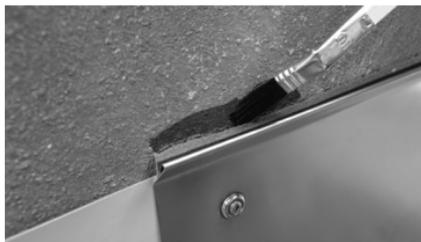
Нанесите грунт Sika® Primer-3 N на контактные поверхности (металл, кирпичная кладка или штукатурка). Дождитесь полного высыхания праймера Sika® Primer-3 N.
