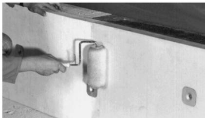
Основание должно быть стойким к растворителям, чистым, сухим, без следов смазки и пыли. Во время перерывов в работе банку с клеем следует плотно закрывать. Клей Sika-Trocal® C 733 можно разбавлять растворителем Sika-Trocal® L 100 (не более 10%).
