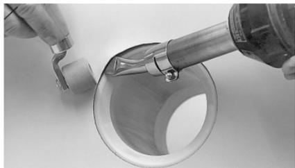
— Приварите мембрану Sikaplan® G к фланцу водосточной воронки S-Drain.
