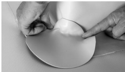
**Или используйте готовую угловую наладку заводского изготовления Sikaplan® Corner1.**
