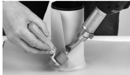
— Сварите вертикальный шов снизу-вверх. Используйте сопло 20 мм.
