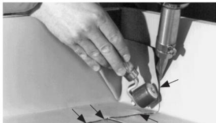
Приварите вертикальный нахлест мембраны Sikarlan® G к вертикальной поверхности парапета и к горизонтальной мембране, как показано на рисунке.
