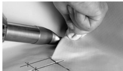
— Приварите складку к горизонтальной мембране, Сварку начинайте из угла.
