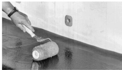
4. Нанесите клей Sika-Trocal® C 733 на нижнюю поверхность кровельной мембраны Sikaplan® G.
