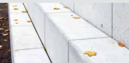
Герметизация швов
