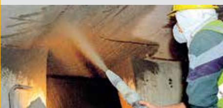
Ремонт и защита бетона
