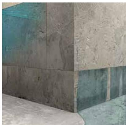
Проникновение воды через рабочий шов бетонирования
