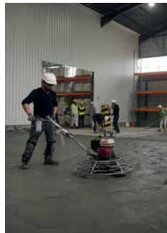
УПРОЧНИТЕЛИ БЕТОННЫХ ПОЛОВ НА ЦЕМЕНТНОЙ ОСНОВЕ (ТОППИНГИ)
