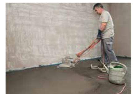
**СТЯЖКИ ВЫСОКОПРОЧНЫЕ ДЛЯ ПОДГОТОВКИ ПОВЕРХНОСТИ ПОД УКЛАДКУ ФИНИШНЫХ ПОКРЫТИЙ**
