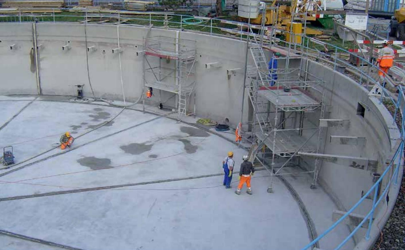
**1 СИСТЕМА ГИДРОИЗОЛЯЦИИ ПВХ-МЕМБРАНАМИ**
