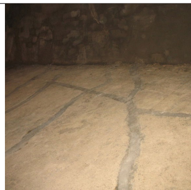
Трещины в ж/б днище резервуара, отремонтированные с помощью MasterEmaco® S 488 и MasterEmaco® 640
