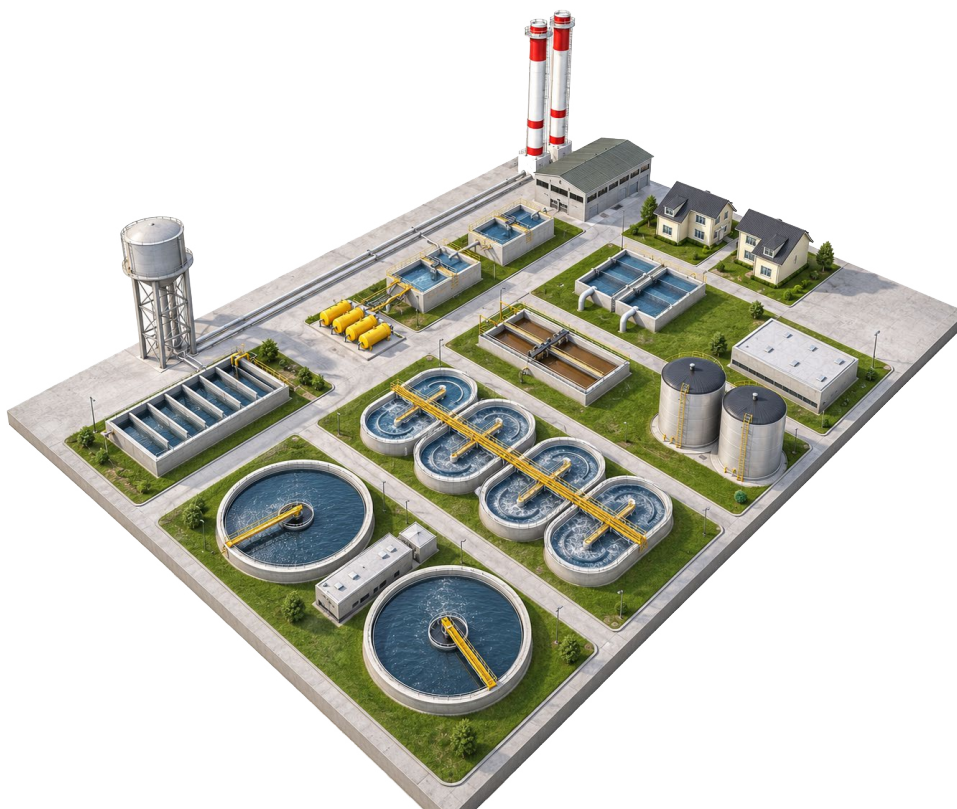
Общий вид комплекса очистных сооружений сточных вод
