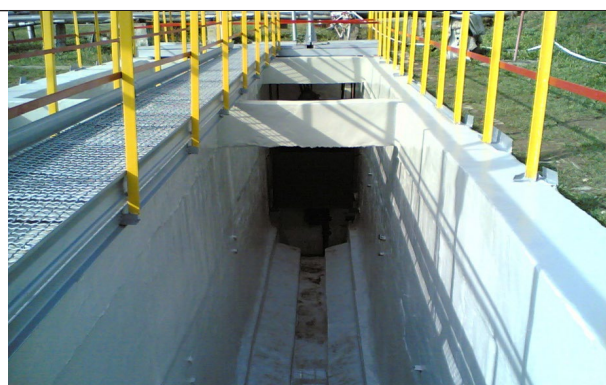
Ручное нанесение гидроизоляционной химстойкой мембраны MasterSeal® M 336
