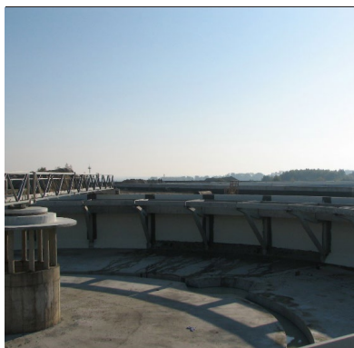
Общий вид аэротенков после нанесения MasterSeal® 588
