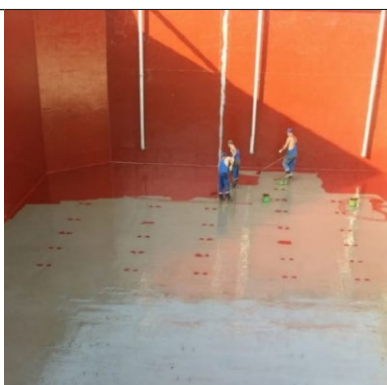
Нанесение химстойкого покрытия MasterSeal® 7000 CR
