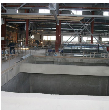
Общий вид резервуаров осветлителей в процессе строительства
