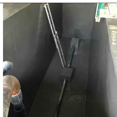
Резервуар после нанесения MasterSeal® 6808
