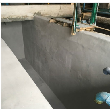
Резервуар после восстановления с помощью MasterEmaco® S 488
