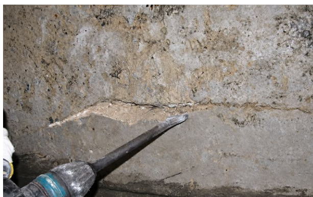
Рисунок 8 – Разделка трещин отбойным молотком
