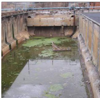
Общий вид резервуаров перед началом работ
