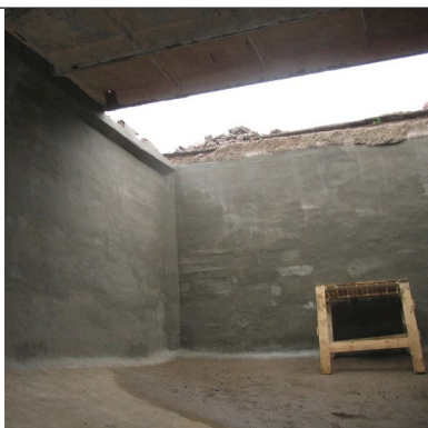
Стеновые панели после восстановления с помощью MasterEmaco® S 488
