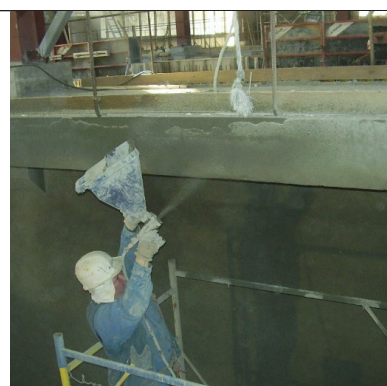
Нанесение гидроизоляционного защитного покрытия MasterSeal® 531 механизированным способом
