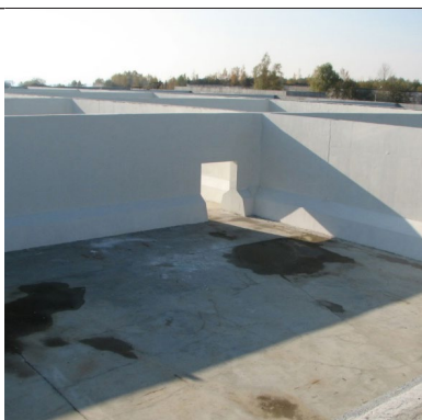
Общий вид вторичных отстойников после нанесения MasterSeal® 588
