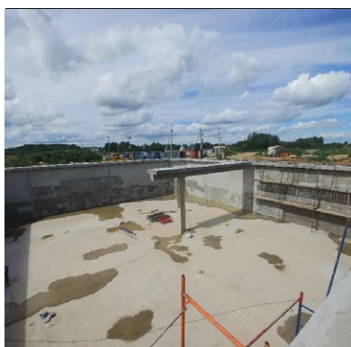
Общий вид резервуара перед нанесением гидроизоляции
