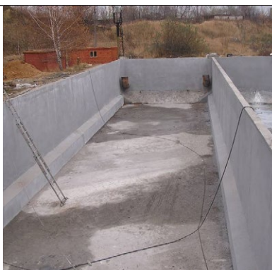
Общий вид резервуара после комплексного ремонта: восстановления поверхности дна, стеновых панелей, межпанельных швов
