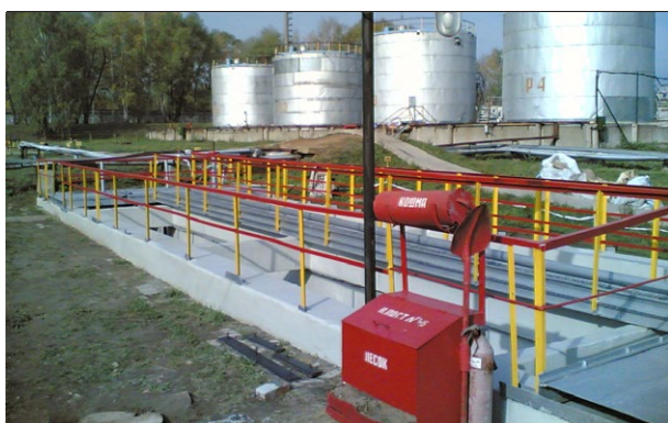
Общий вид резервуара после нанесения химстойкой гидроизоляционной системы MasterSeal® 6336
