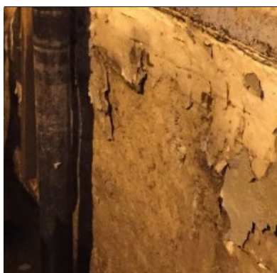
Общий вид резервуара перед капитальным ремонтом
