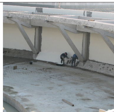
Нанесение гидроизоляционного защитного покрытия MasterSeal® 588
