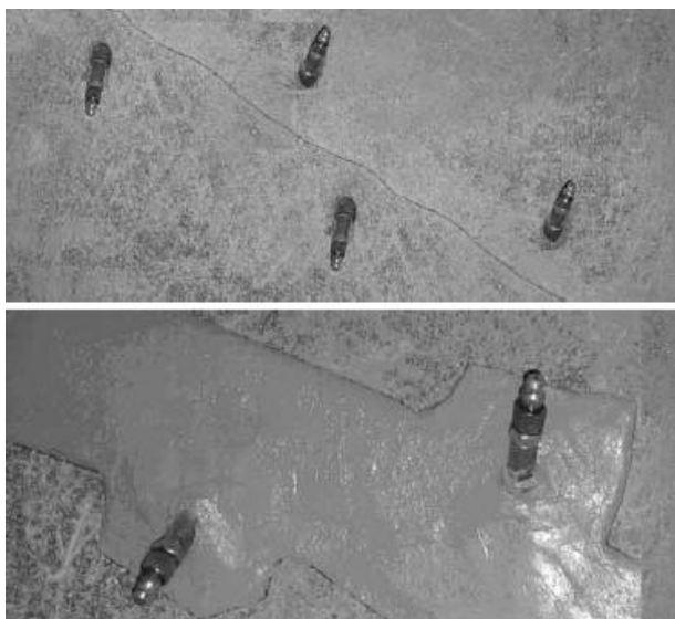
Рисунок 1. Пакеры, установленные вокруг трещины и герметизированные эпоксидным клеем Sikadur-31+ RU или Sika Anchorfix
