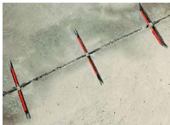
Рисунок 5. Установка стяжек в каналы, открытые в трещинах
