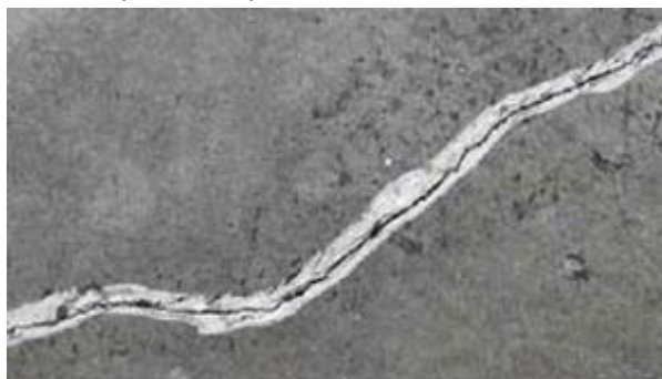
Рисунок 3. V-образная канавка вдоль трещины
