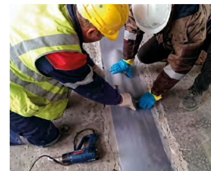
Используемые материалы: Гидроизоляция деформационного шва при строительстве подземной части здания системой Sikadur-Combiflex® Месторасположение: Санкт-Петербург
