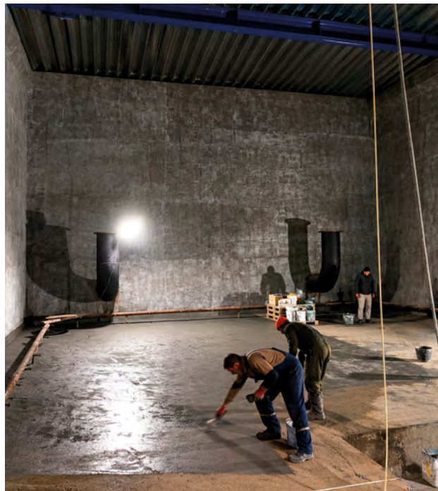
Используемые материалы: Гидроизоляция резервуара с использованием высокоэластичного цементно-полимерного состава SikaTop®-550 Seal Месторасположение: Ленинградская область
