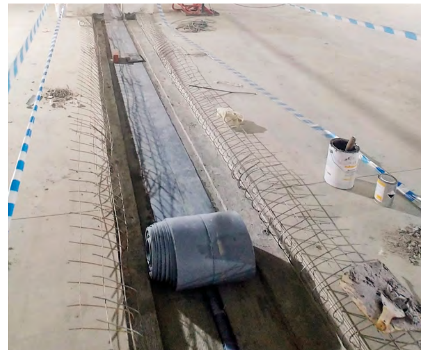
Используемые материалы: Гидроизоляция деформационного шва при строительстве подземной части здания системой Sikadur-Combiflex® Месторасположение: Санкт-Петербург
