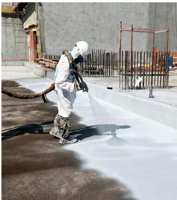
Используемые материалы: Гидроизоляция стилобата напыляемой мембраной на основе полимочевины Sikalastic®-8440 RU Месторасположение: Свердловская область
