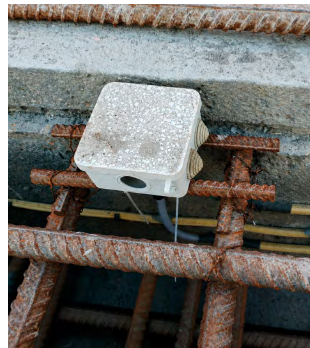
Используемые материалы: Гидроизоляция швов водонепроницаемой конструкции с применением инъекционной системы SikaFuko® Месторасположение: Ямало-Ненецкий автономный округ
