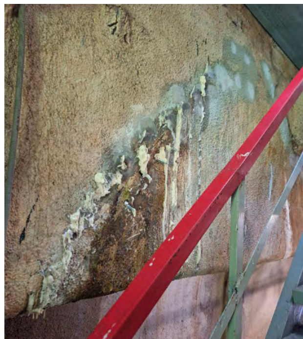
Используемые материалы: Инъектирование трещин в подземном резервуаре с применением SikalInject®-155 на ПУ основе Месторасположение: Ярославль
