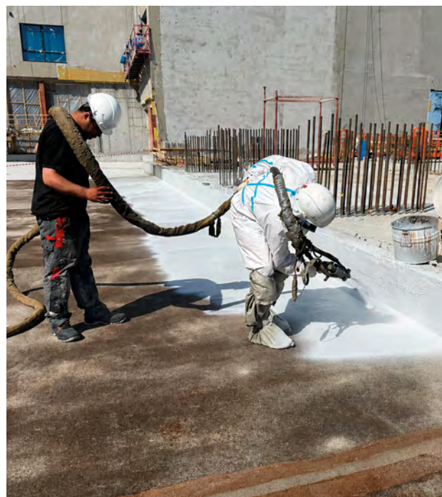
Используемые материалы: Гидроизоляция стилобата напыляемой мембраной на основе полимочевины Sikalastic®-8440 RU Месторасположение: Свердловская область
