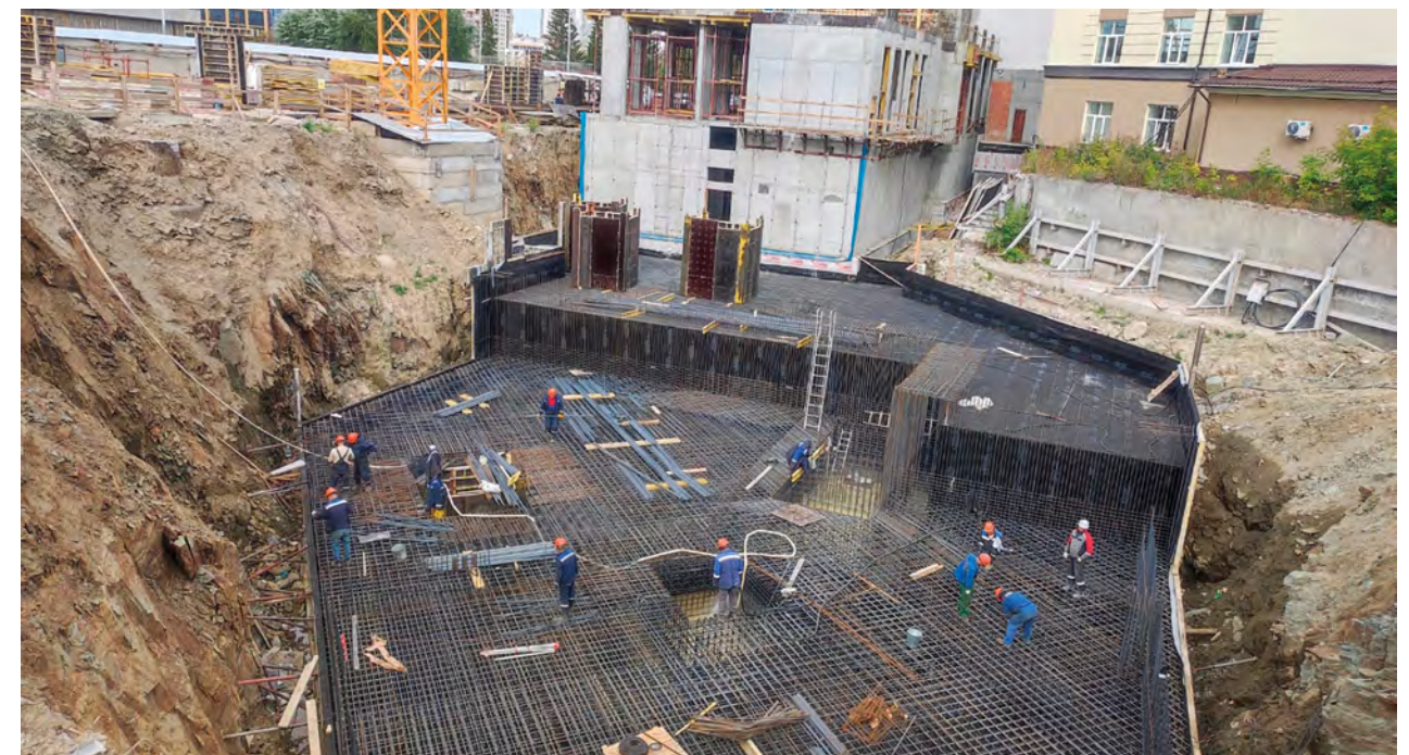
Используемые материалы: Гидроизоляция заглубленной части сооружения системой SikaProof®-754 Месторасположение: Воронеж
