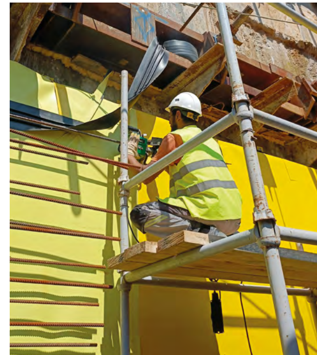
Используемые материалы: Гидроизоляция заглубленной части сооружения системой Sikaplan® WP Месторасположение: Москва
