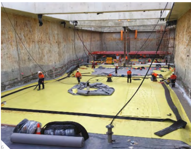
Рулонные полимерные мембраны с секционированием
