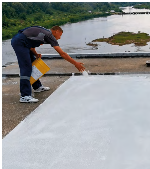
Используемые материалы: Гидроизоляция железобетонных пролетных строений моста с использованием Sikalastic®-822 RU Месторасположение: Московская область
