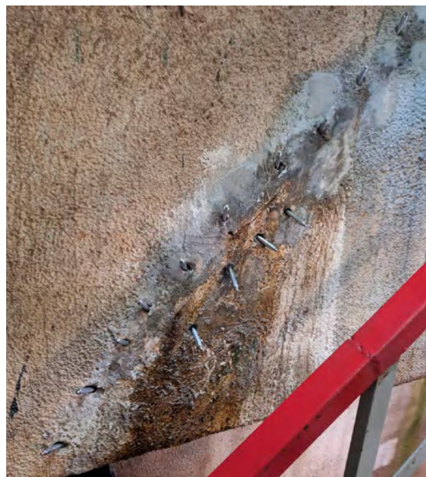
Используемые материалы: Инъектирование трещин в подземном резервуаре с применением SikalInject®-155 на ПУ основе Месторасположение: Ярославль
