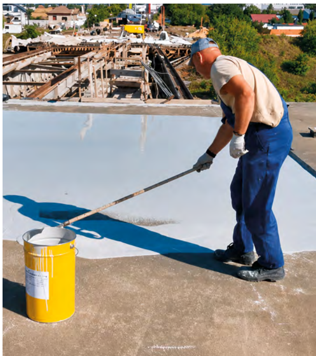
Используемые материалы: Гидроизоляция железобетонных пролетных строений моста с использованием Sikalastic®-822 RU Месторасположение: Московская область
