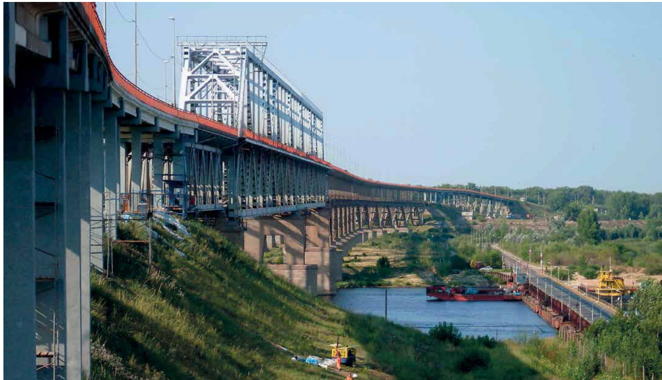
Мост через р. Волга в Нижнем Новгороде
