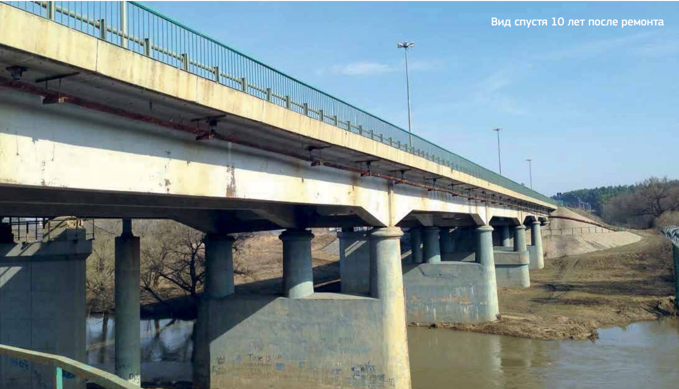
Мост через р. Протва, Московская область
