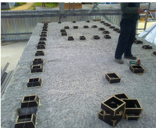
Фото 5. Сплошная подготовка основания
