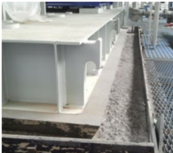
Фото 20. Переустановка опалубки с созданием декоративного плеча подливки с обратным углом
