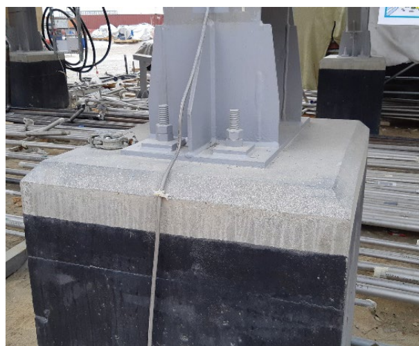
Фото 4. Подливка металлоконструкций
