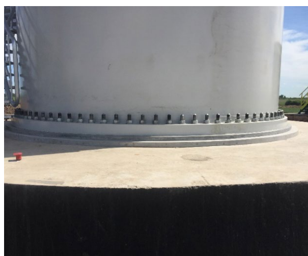
Фото 2. Подливка ветрогенератора
