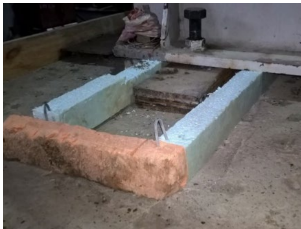
Фото 10. Удаляемые элементы временной опалубки
