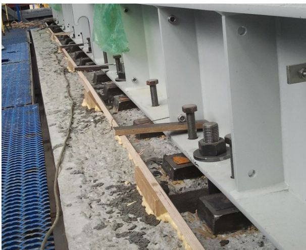
Фото 16. Герметизации опалубки
