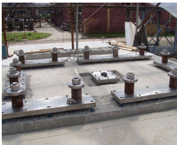
Фото 6. Подготовка основания под опорными частями
