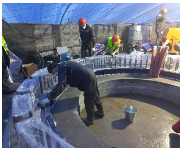
Фото 8. Подливка фланца ветрогенератора, температура -7^{\circ}\text{C} снаружи теплового контура
